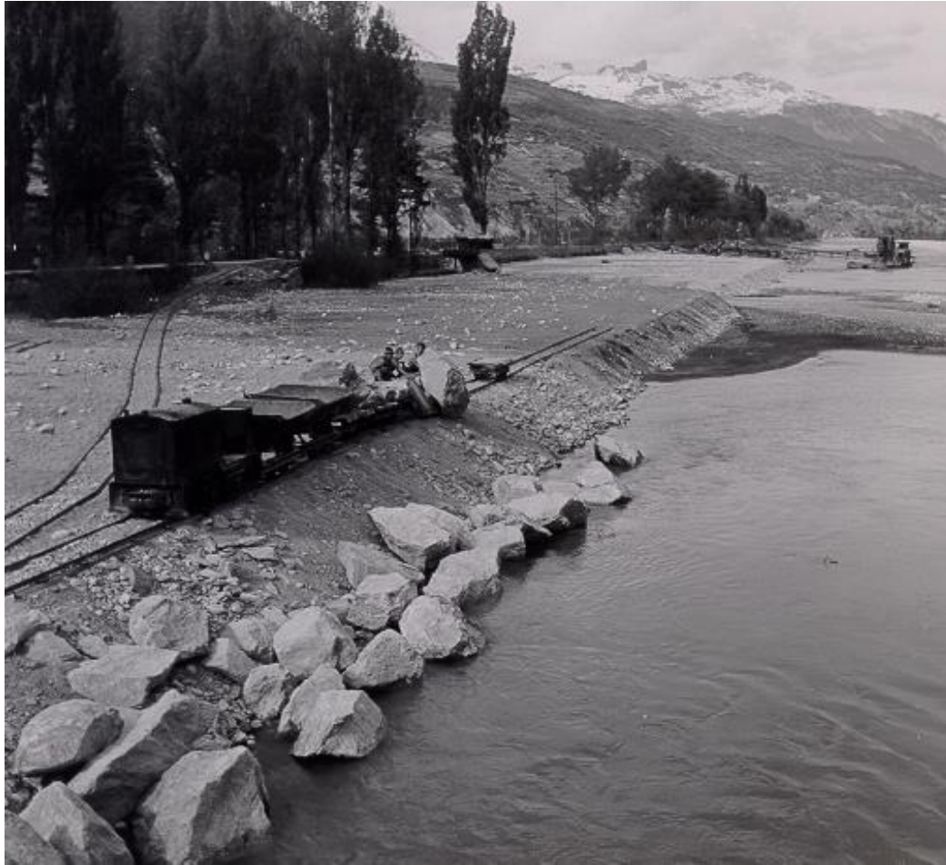
Cordons d'enrochement – Transport de matériel Rétrécissement du lit du Rhône Région de Saint-Léonard
