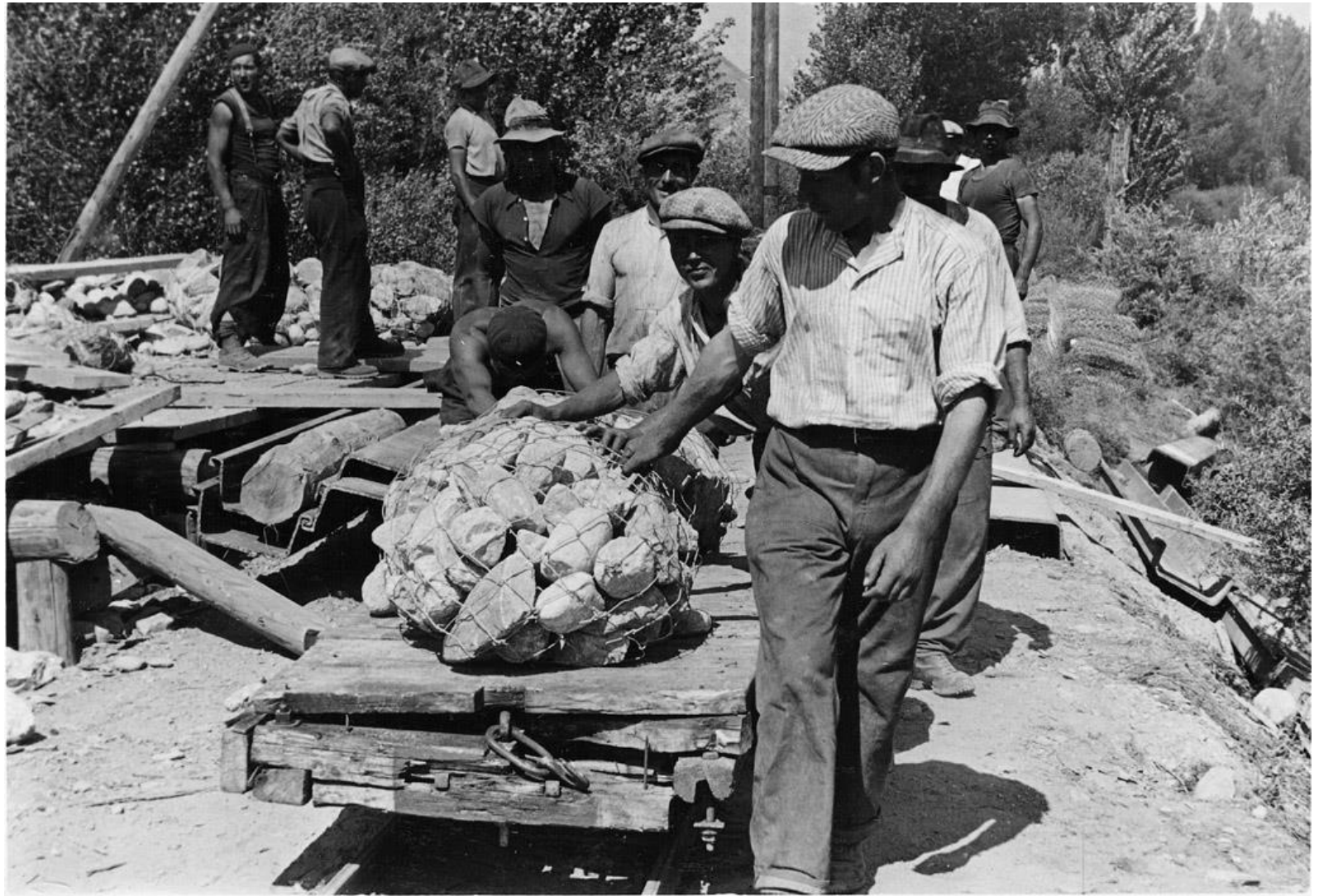
Uferbefestigung mit Steinblöcken – Materialtransport Verengung des Rhonebetts
