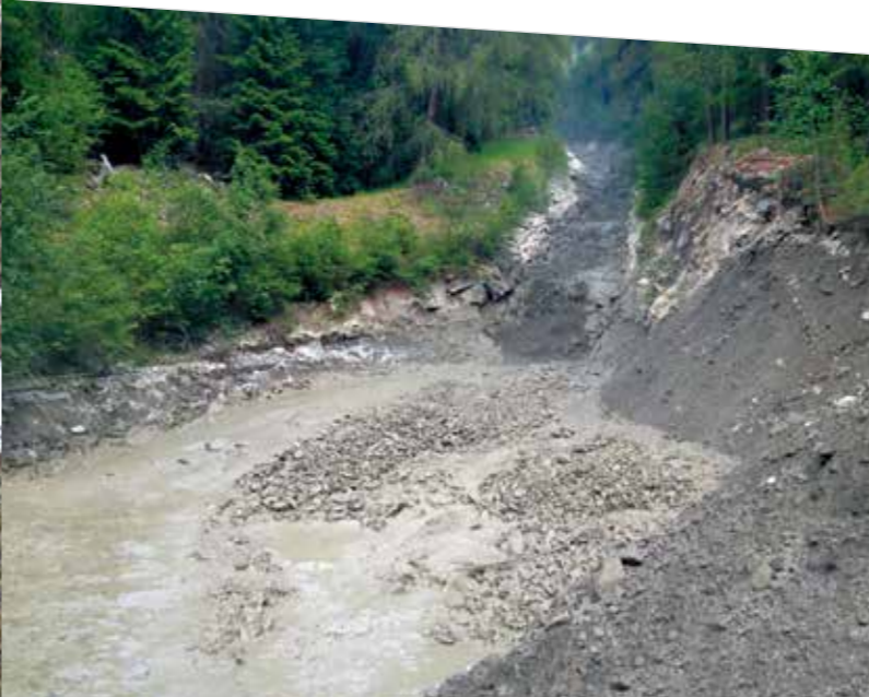
17.06.2013: Mit Schlamm vermischter Schutt erreicht den bereits stark gefüllten Geschiebesammler.
